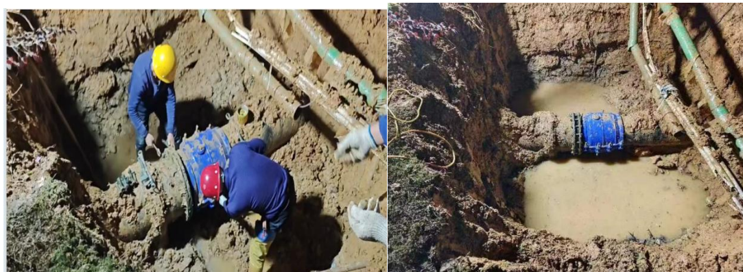
图 2 现场抢修照片
