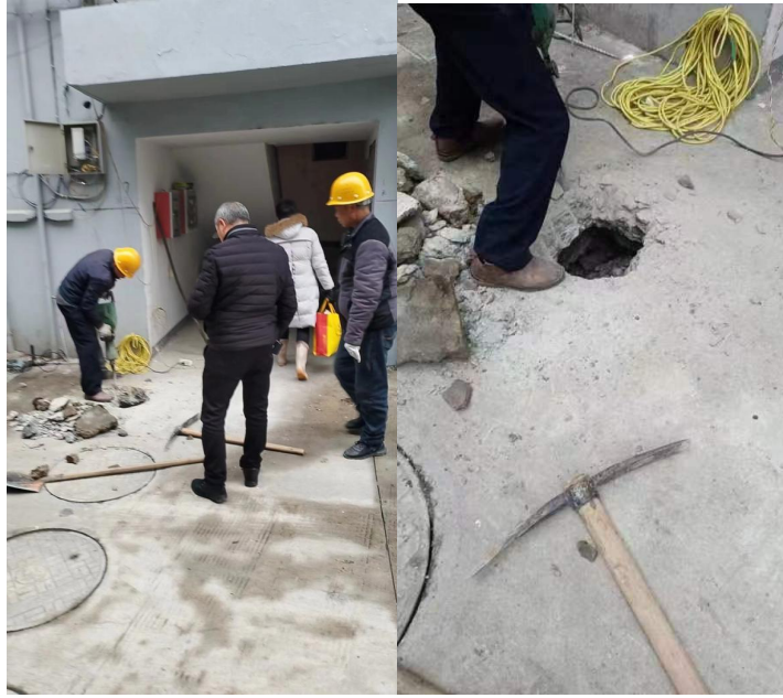
图 2 现场抢修照片
